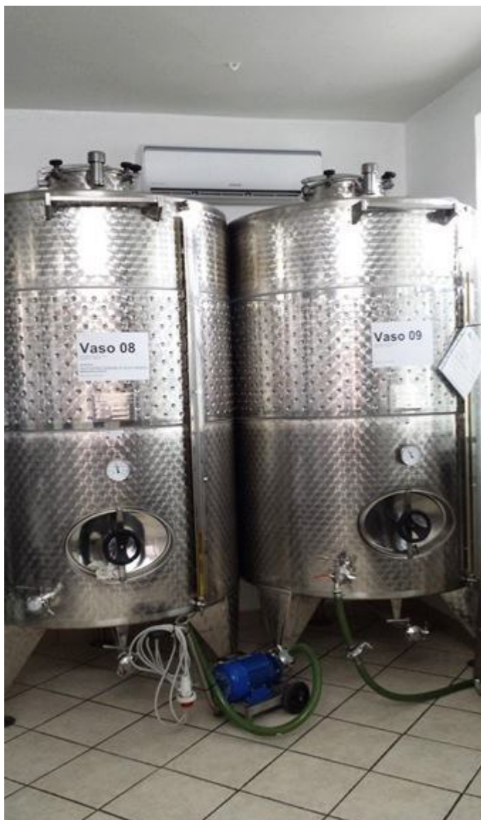
Fig. n. 58 – Sistema per lo stoccaggio dell’olio con serbatoi in acciaio inossidabile muniti di fondo conico per lo scarico delle morchie e conservazione dell’olio sotto azoto
